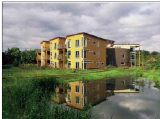
Pour l'électricité ce concept est basé sur l'usage de l'énergie solaire passive, sur la qualité de l'isolation et sur l'électricité photovoltaïque. Chaque maison dispose d'un chauffage solaire pour l'eau.
