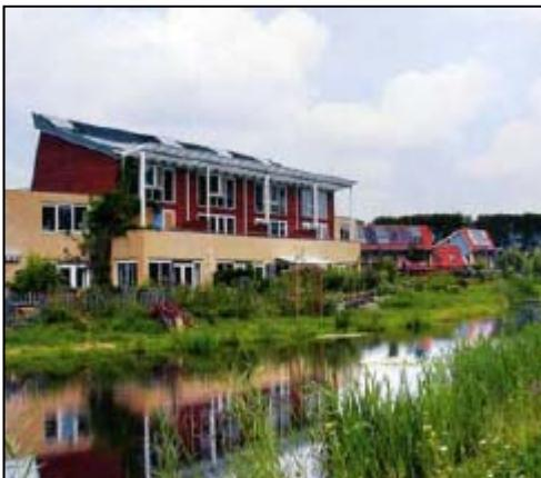
Les maisons sont constituées d'une ossature en bois et de béton cellulaire ou expansé, le sol étant peu solide. Le bois, des essences européennes de type pin, provient de forêts. A l'intérieur l'hygrométrie est régulée grâce aux matériaux utilisés. Les peintures sont naturelles et l'isolation est réalisée en laine ou en cellulose.
