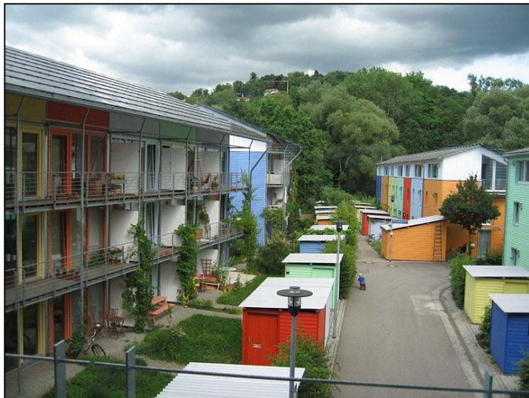
Construit suivant les normes HQE, les logements sont alimentés par énergie solaire, ils produisent plus d'énergie qu'ils n'en consomment. Les autres bâtiments du quartier respectent également un grand nombre de principes issus des normes HQE, telles les toitures végétalisées, une exposition optimisée à la chaleur solaire, l'emploi de panneaux solaires et de matériaux écologiques pour la construction.
