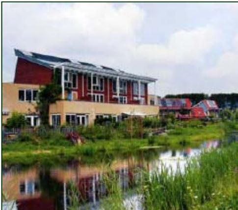
Les maisons sont constituées d'une ossature en bois et de béton cellulaire ou expansé, le sol étant peu solide. Le bois, des essences européennes de type pin, provient de forêts. A l'intérieur l'hygrométrie est régulée grâce aux matériaux utilisés. Les peintures sont naturelles et l'isolation est réalisée en laine ou en cellulose.
